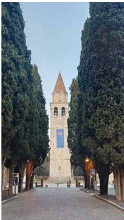
Il Campanile della Basilica di Aquileia
